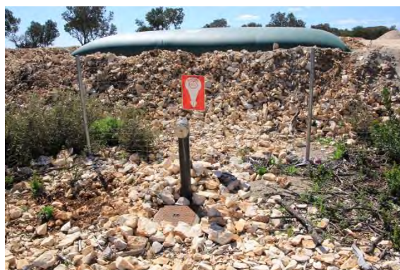
Raccord pompier à l'extérieur de l'emprise du projet pour faciliter son accessibilité
