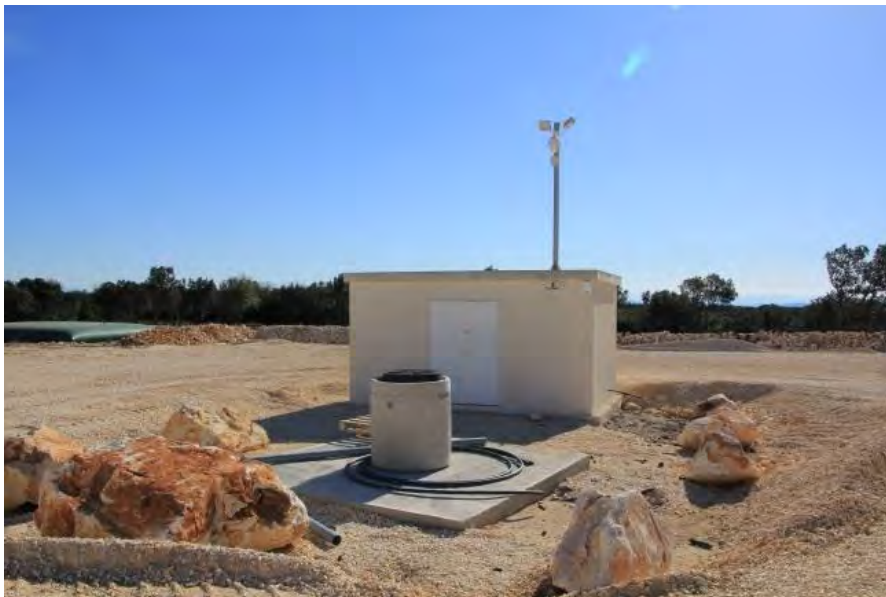
Photographie du forage réalisé en mars 2016 sur la carrière de CDG
